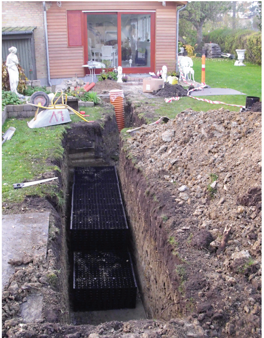
Figur 14: Faskine under udførelse. Tagvandet ledes via en sandfangsbrønd (lodret orange rør) til faskinen i billedets forgrund. Faskinen er opbygget af plastkassetter. Lindevang i Brøndby Foto Spildevandscenter Avedøre.
