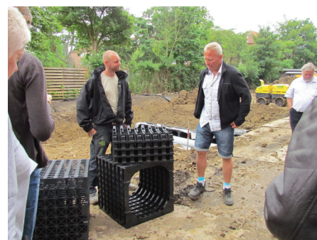
Figur 17: Faskinekassetter ved anlægsarbejde i Valby. Foto Orbicon
